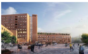
Oslo universitetssykehus HF Nye Rikshospitalet
